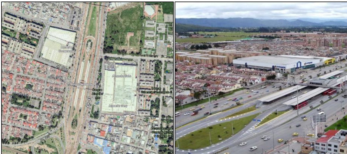
Ilustración 25. Aerofotografía y vista del Portal Norte, ubicado a la altura de la Avenida Carrera 45 (Autopista Norte) con Calle 175.
