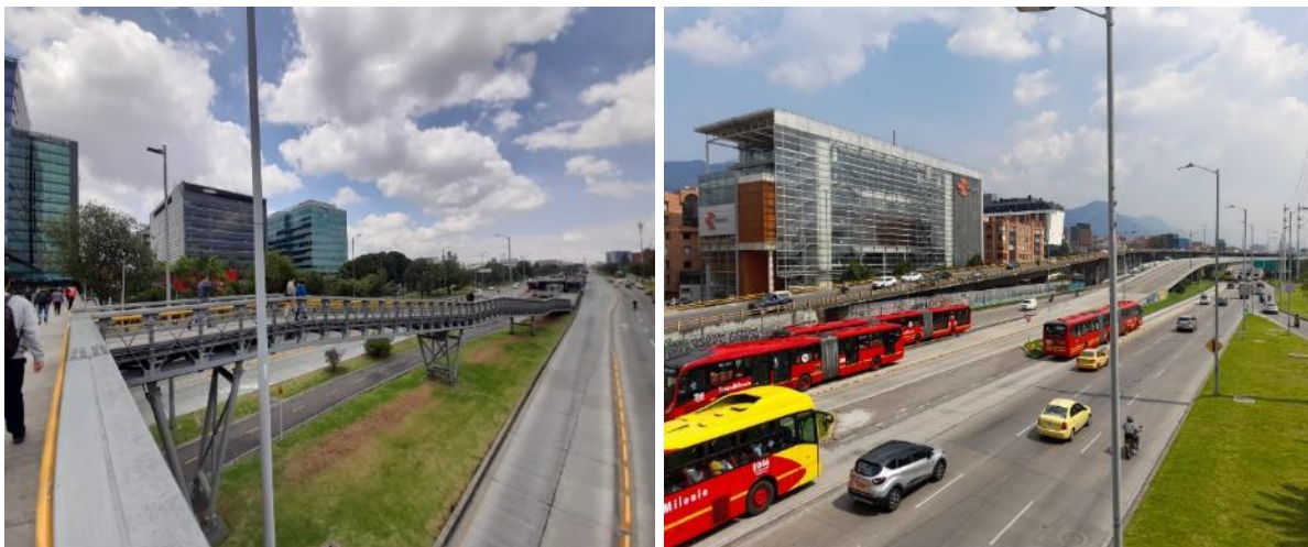
Ilustración 36. Entorno general del Sistema Troncal de TransMilenio. Fuente propia TRANSMILENIO S.A.
