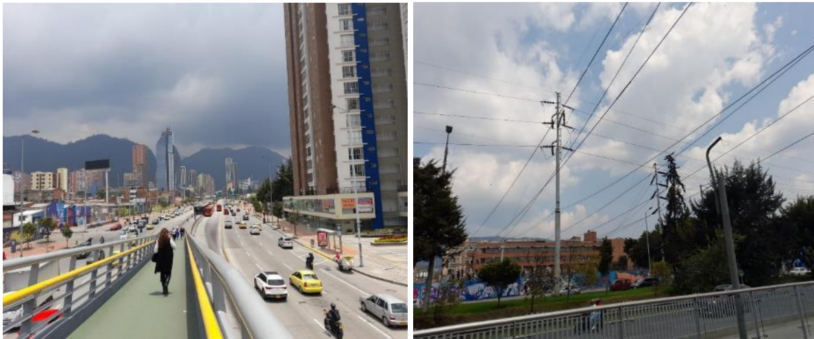
Ilustración 35. Entorno general del Sistema Troncal de TransMilenio. Fuente propia TRANSMILENIO S.A.
